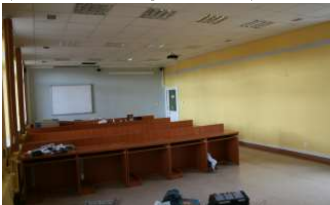
Rys. 2: Sala w trakcie prac remontowych.
